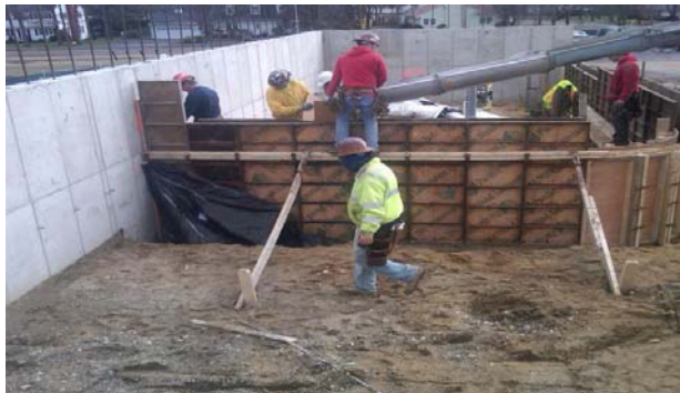
Concrete pour at generator room
